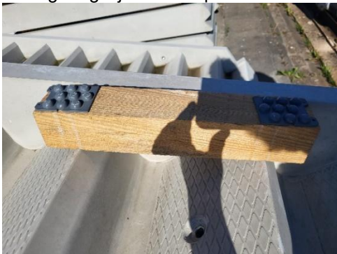
Positie onderstopshout tijdens opstapelen elementen
