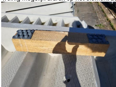
Positie onderstoppingshout tijdens opstapelen elementen
